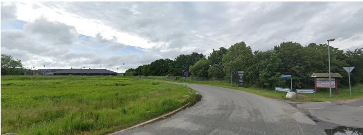
Figur 4: Den eksisterende vejadgang til området fra Havnevej via Havnesvinget/Havnelinien (Google Streetview).
